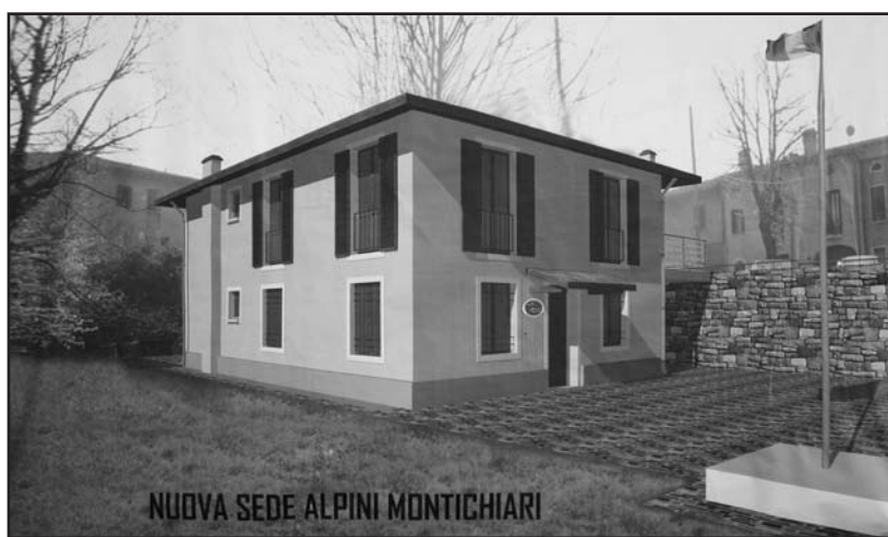
Riproduzione al computer della nuova sede degli Alpini, in corso di costruzione in via Pellegrino. (Foto Mor)
